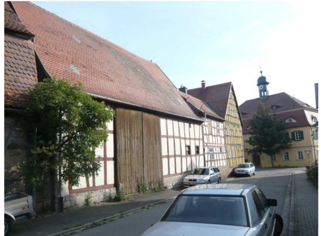
Schweheimer Gasse – Abfolge von Scheunen / Nebengebäuden
