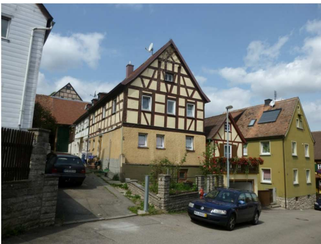
Erbsengasse 6 bis 10 – Dachlandschaft mit Satteldächern und giebelständigen Gebäuden
