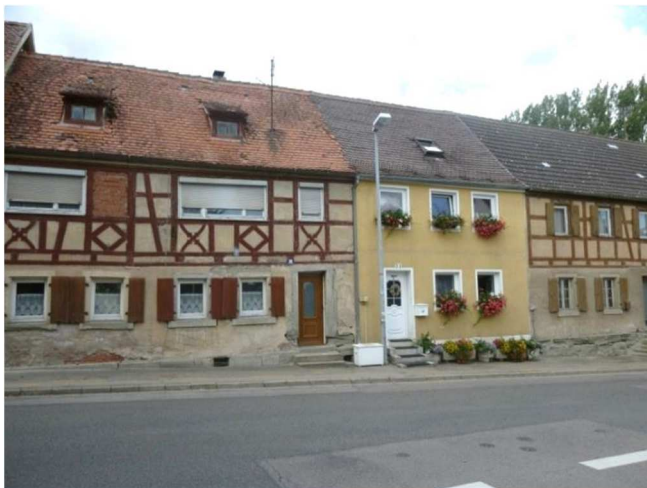
Innere Bahnhofstraße 31-33: sehr geringe Grundstücksgröße bzw. hohe Konzentration kleiner Grundstücke
