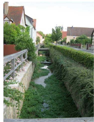
Rothenburger Straße – offener Bachlauf
