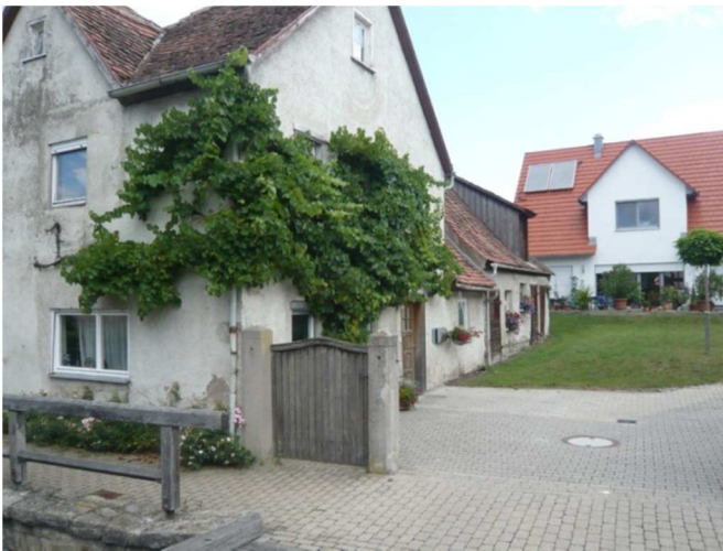
Rothenburger Straße 11: Altsubstanz und Neubau
