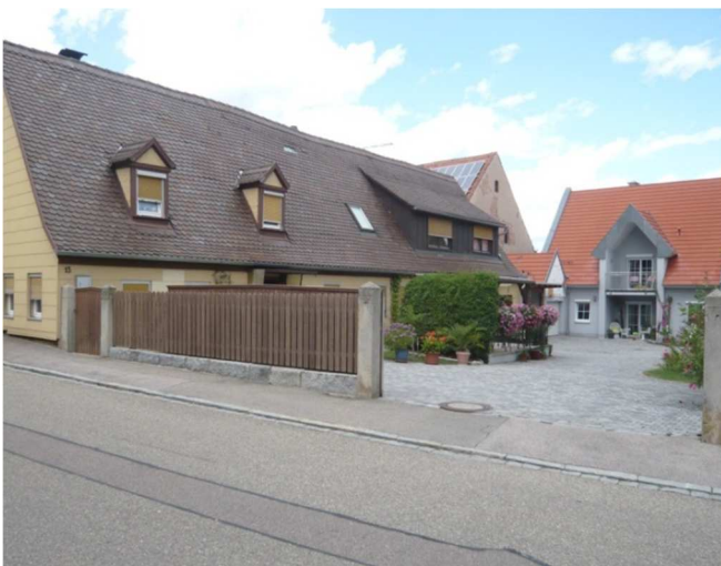
Rodgasse 11: Zufahrt zu rückwärtigem Neubau nur über benachbartes Grundstück möglich
