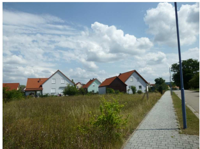
Allgemeines Wohngebiet „Hinter den Gärten“ mit Baulücken
